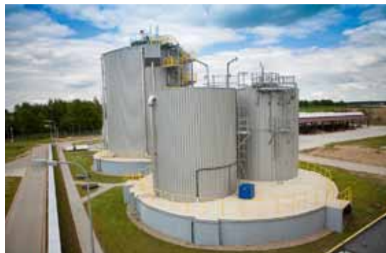
Zmodernizowana oczyszczalnia ścieków w Żydomicach.
