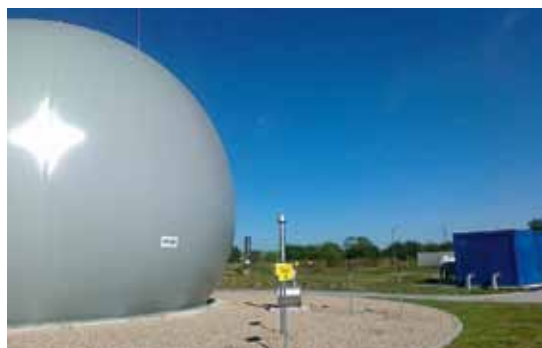
Biogazownia w oczyszczalni ścieków Zduńskiej Woli.
