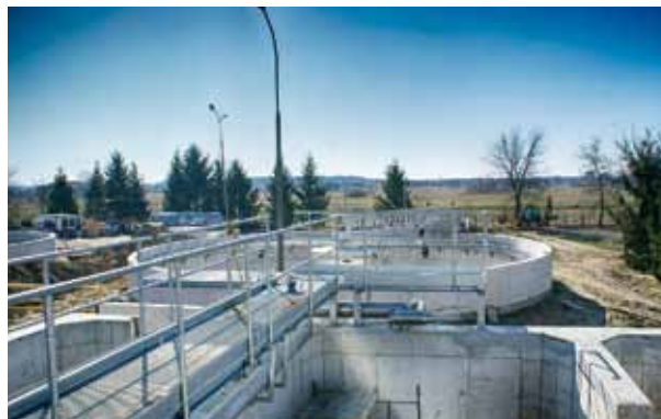
Rozbudowa oczyszczalni ścieków w Opocznie.
